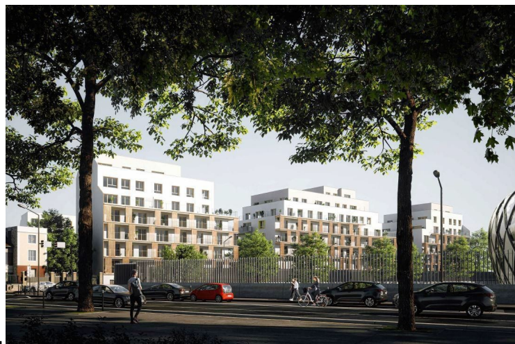
Illustration 4: vue depuis l'avenue Marcel Cachin, avec data center sur la droite (étude d'impact, p. 37)
