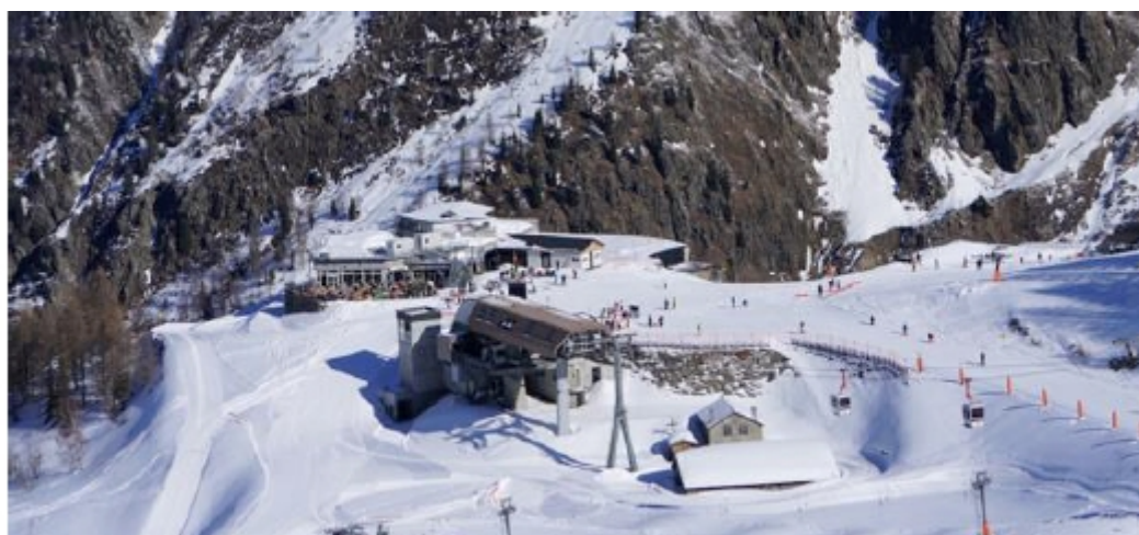
La gare intermédiaire aujourd'hui après incendie
