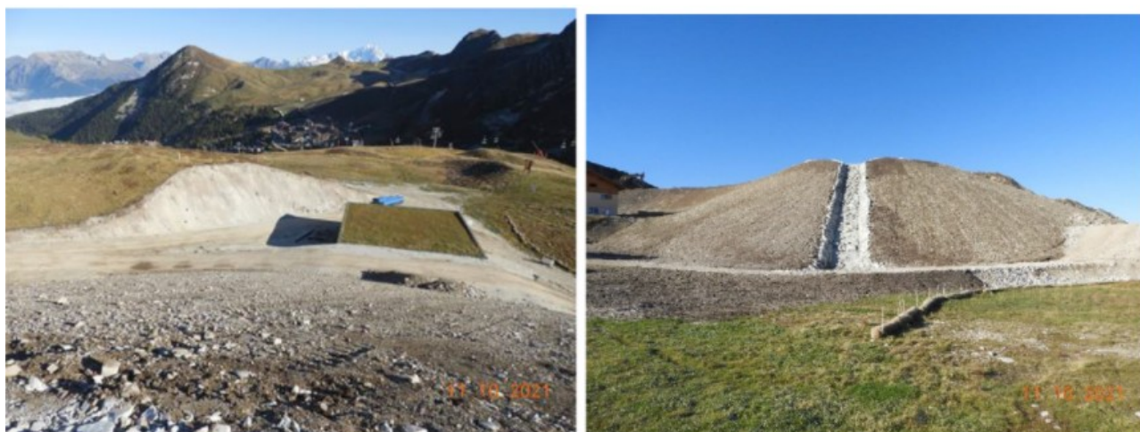
Figure 9: Prise de vue des travaux de la retenue en 2021 - Source : dossier
