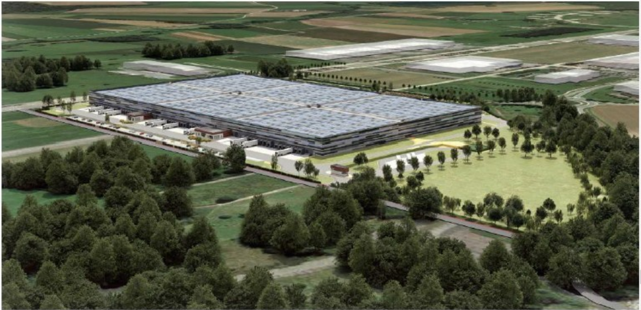
Extrait du dossier (vue aérienne du projet de construction depuis le sud en direction du nord-ouest)
