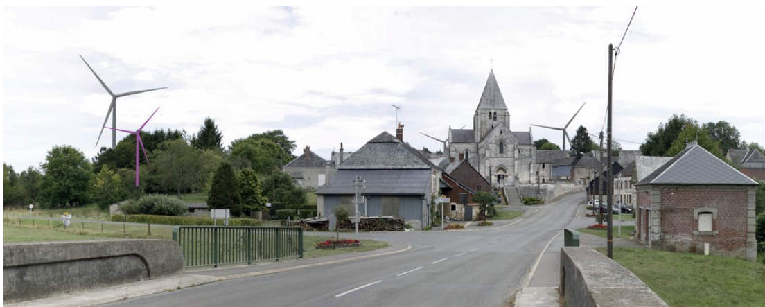
Figure 7 – Vue depuis l'entrée ouest d'Hannappes
