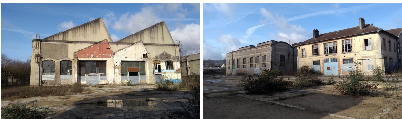
Un site essentiellement artificialisé, au bâti délaissé
