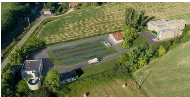
Figure 3 : vue aérienne future usine de Fonneuve issue de l'étude d'impact
