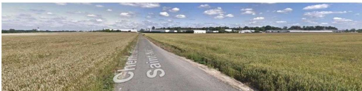
Illustration 10: Vue sur le site vers le nord, depuis le Chemin de la Croix Saint-Nicolas (source : étude d'impact, p. 112). Le projet se situera à droite
