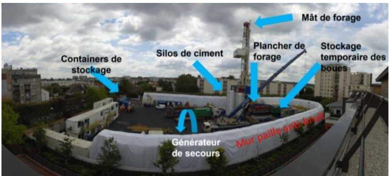
Figure 12: Exemple d'un dispositif anti-bruit sur un chantier de forage géothermique. Source : Étude d'impact, p. 154.
