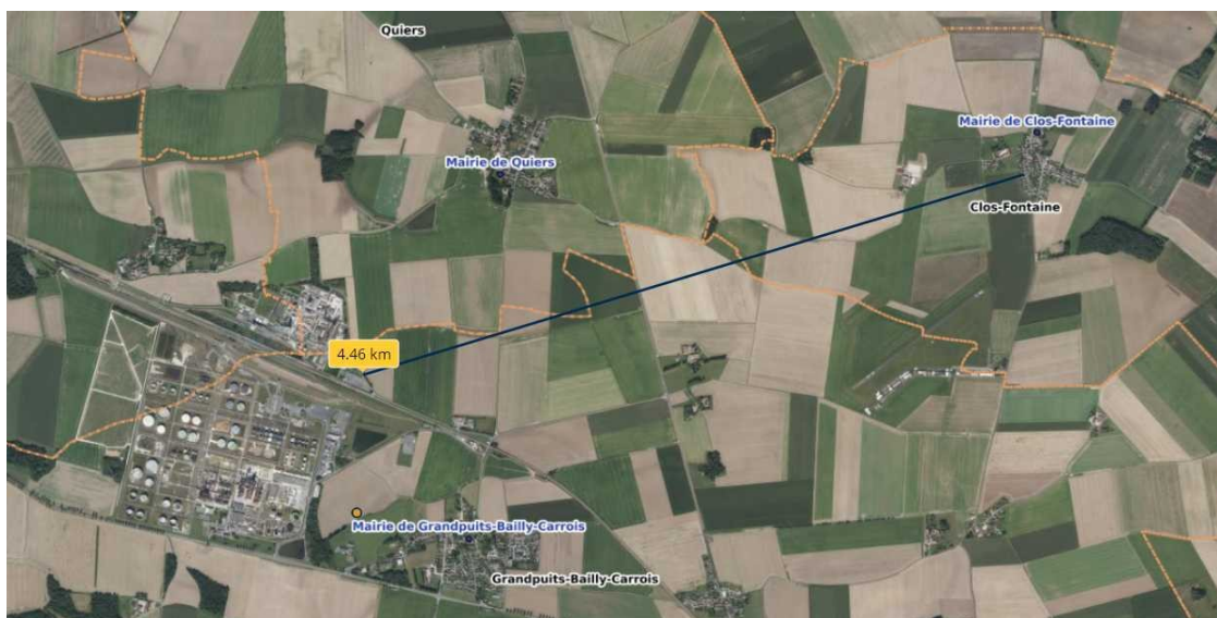
Figure 10: Distance entre la partie urbanisée de la commune et les sites industriels de TotalEnergies et de Boréalys – Source Géoportail
