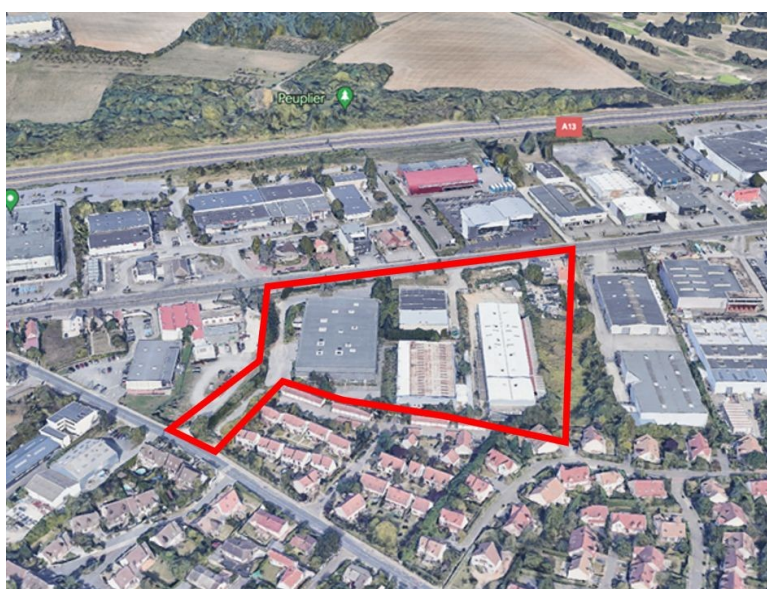
Figure 2: le périmètre du projet à l'interface entre une ZAE et un ensemble pavillonnaire
