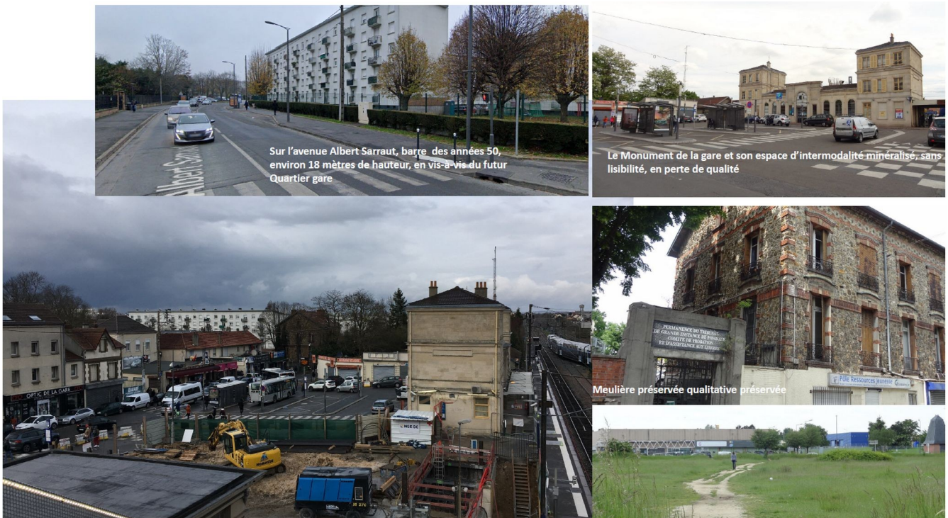
Figure 10: Vues présentant l'état initial de la place de la Gare (p.3 de la note)
