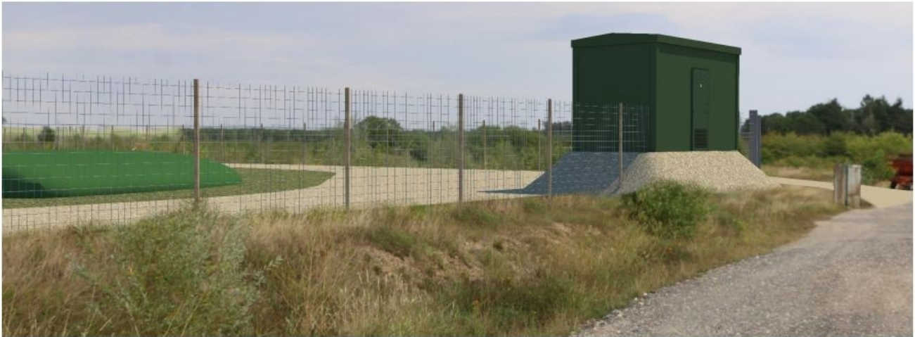
Illustration 6: principale construction en élévation sur le site du projet - résumé non technique p.42
