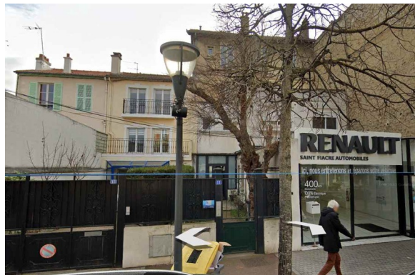
Figure 6 : Bâtiments démolis bld Fernand Hostachy Source Google Maps
