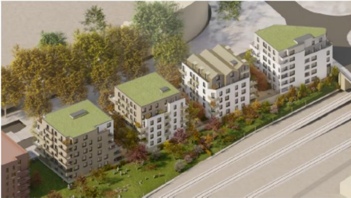
Figure 5: Vue 3D du projet. On note notamment la proximité des logements par rapport aux voies ferrées, représentées ici en bas à droite de l'image (EI p. 133).
