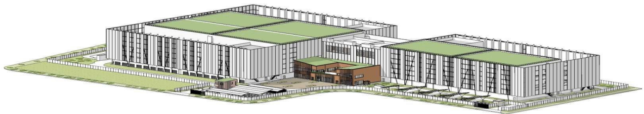
Figure 5: Vue en perspective des bâtiments du data-center (source : description du projet, p. 26)
