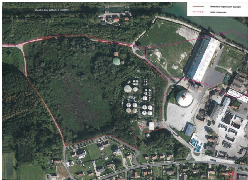
Figure 2: Photographie aérienne du site (source : dossier de permis de construire, PC-01)
