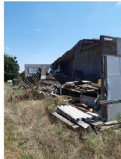
Stockage de tuiles en fibre-ciment cassées potentiellement amiantées
