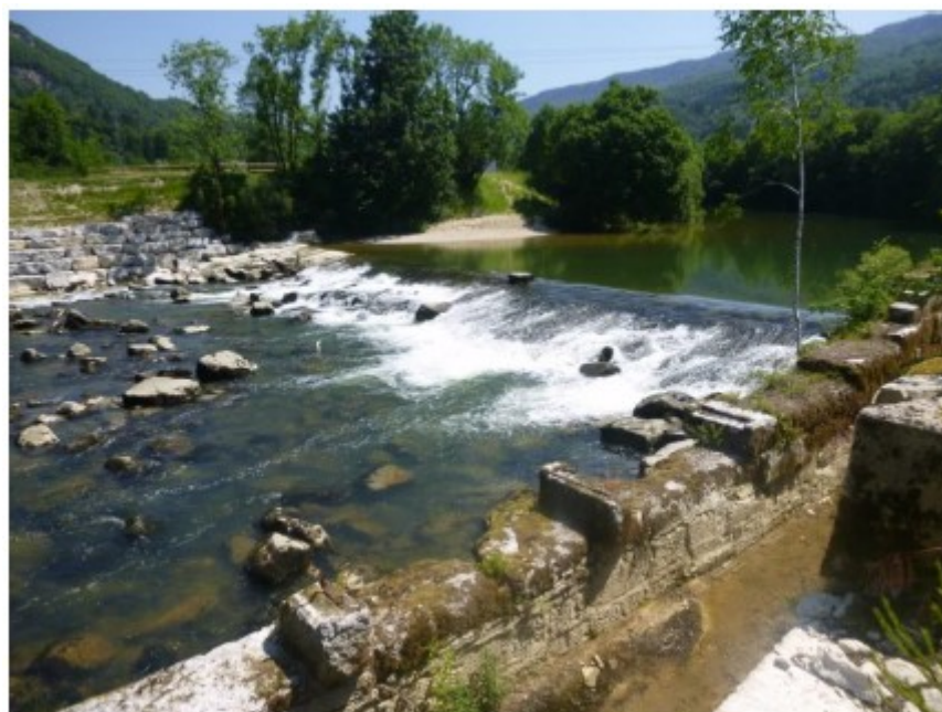
Vue du seuil depuis la rive gauche (extrait du dossier d'étude d'impact)
