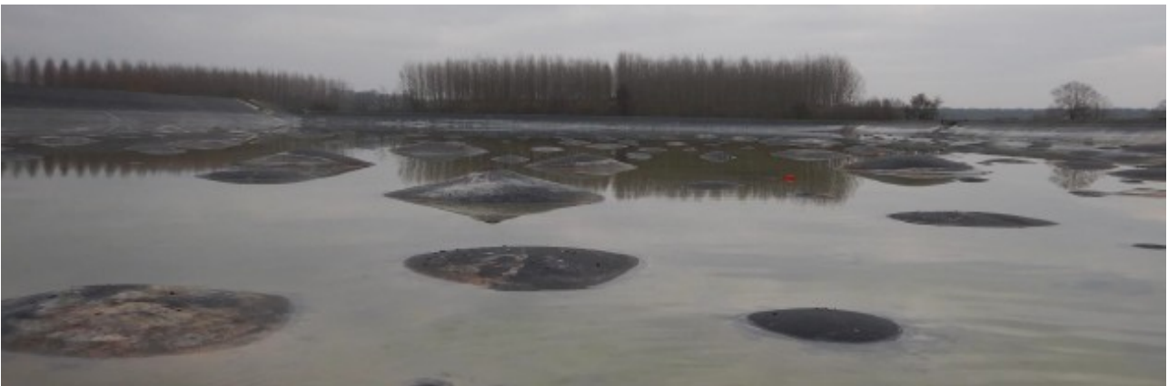
Figure 3 : Photo des bulles de gaz se formant sur bassin (Source : Étude d'impact annexe 3)
