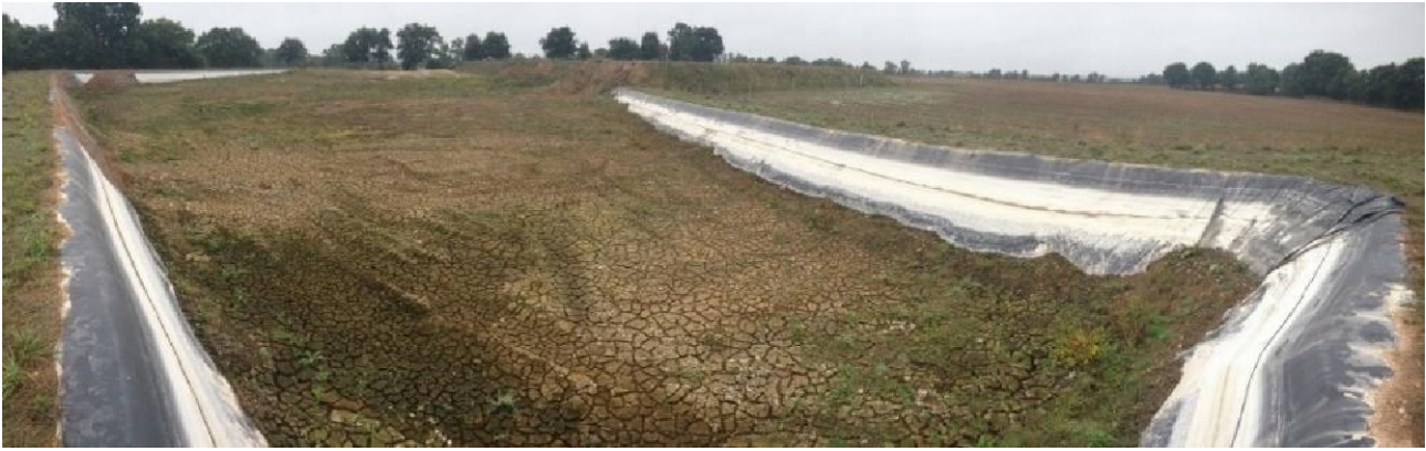
Exemple de bassin de déshydratation avec géomembrane
