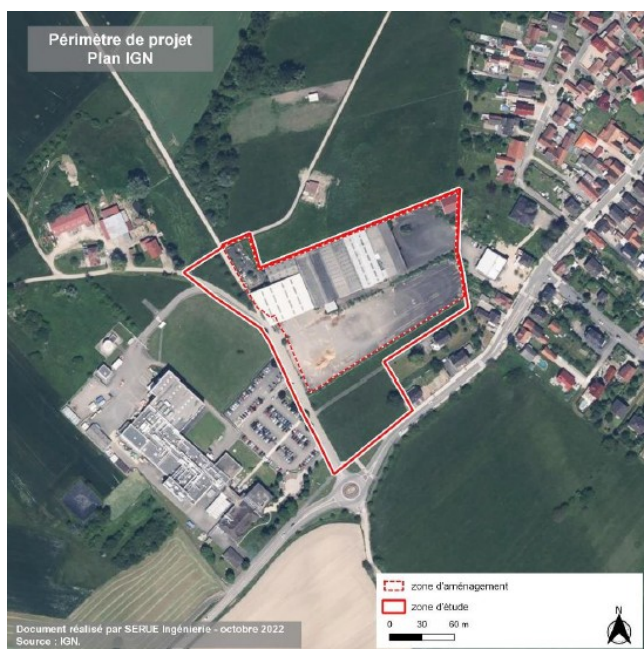
Figure 1 : photo aérienne de la zone d'étude et de la zone d'aménagement avant démolition
