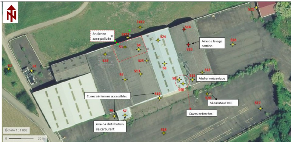
Figure 4 : Photographie aérienne faisant apparaître la localisation des sondages (investigations menées le 24 avril 2019) - Légende en note de bas de page 6
