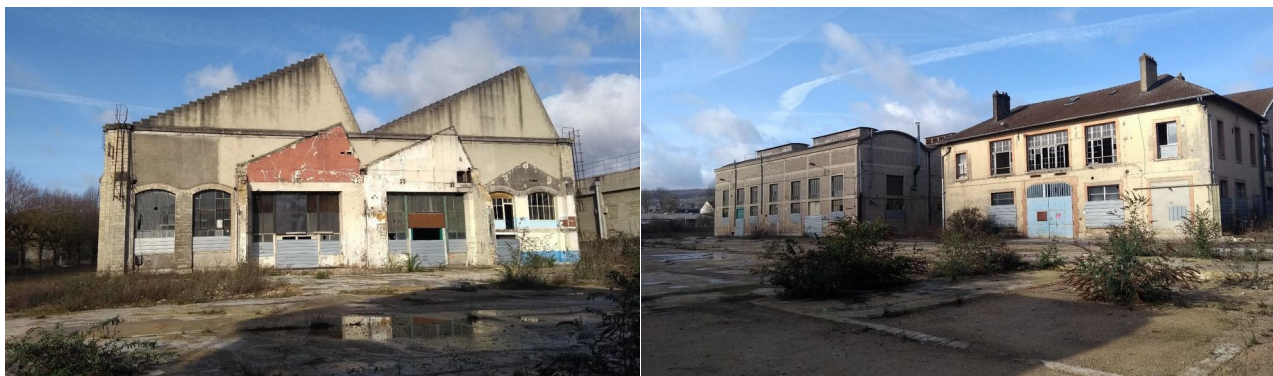
Un site essentiellement artificialisé, au bâti délaissé
