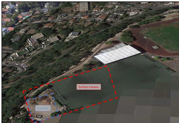
Figure 5 : Vue actuelle du site de l'emprise chantier - Source : Étude d'impact- Figure 40 p.82
