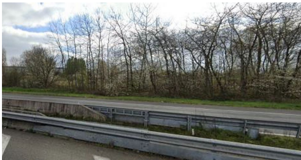
Figure 7 : Terres pleines et talus végétalisés le long de l'A10 (source: rapport de présentation de Villejust, p.21)
