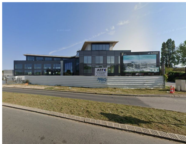
Figure 12 : Photographie du bâtiment en construction depuis la rue Étienne de Jouy, datant d'août 2024 (source : Google street view)
