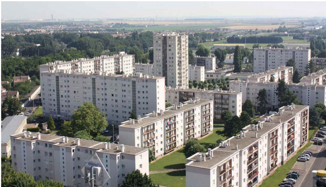
Figure 7: La quartier du Parc de la Noue (1959-1963) à rénover - Villepinte Source: https://www.epfif.fr
