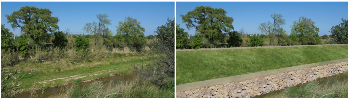
Figure n° 12 : exemple de digue avant / après travaux
