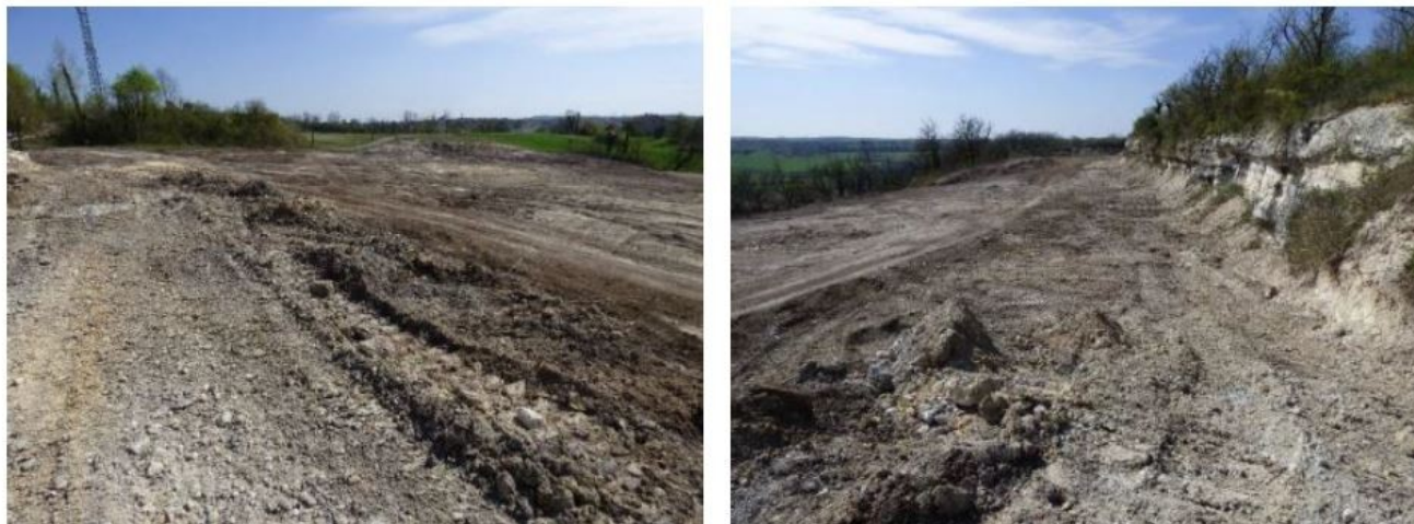
Destruction des habitats naturels avant la réalisation de l'état initial
