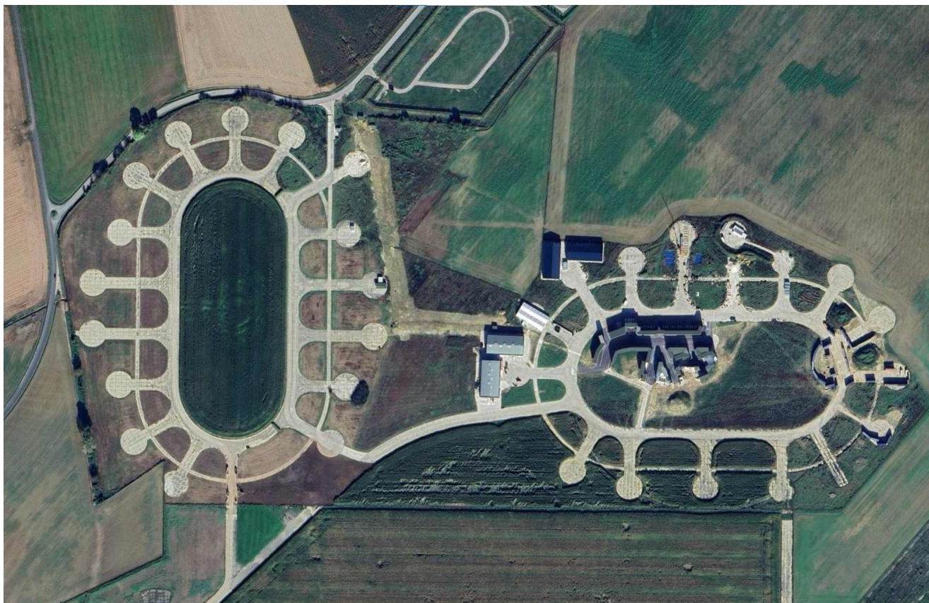
Illustration 2 : État actuel du site du projet. Sur la « marguerite » Est, on perçoit la réalisation récente de cinq bâtiments sur les « pétales » et des décors extérieurs, principalement au centre mais aussi sur certaines pétales (source : Google Maps, 2025)
