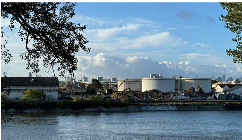
Illustration 4- Chantier en septembre 2023 (© Association Protection Berges de Seine )
