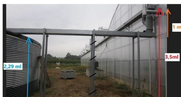
Figure 10 : Photographie d'illustration du collecteur aérien des eaux de pluie alimentant les réservoirs de récupération (source : Pièce 2 - Notice descriptive du projet, p.21)
