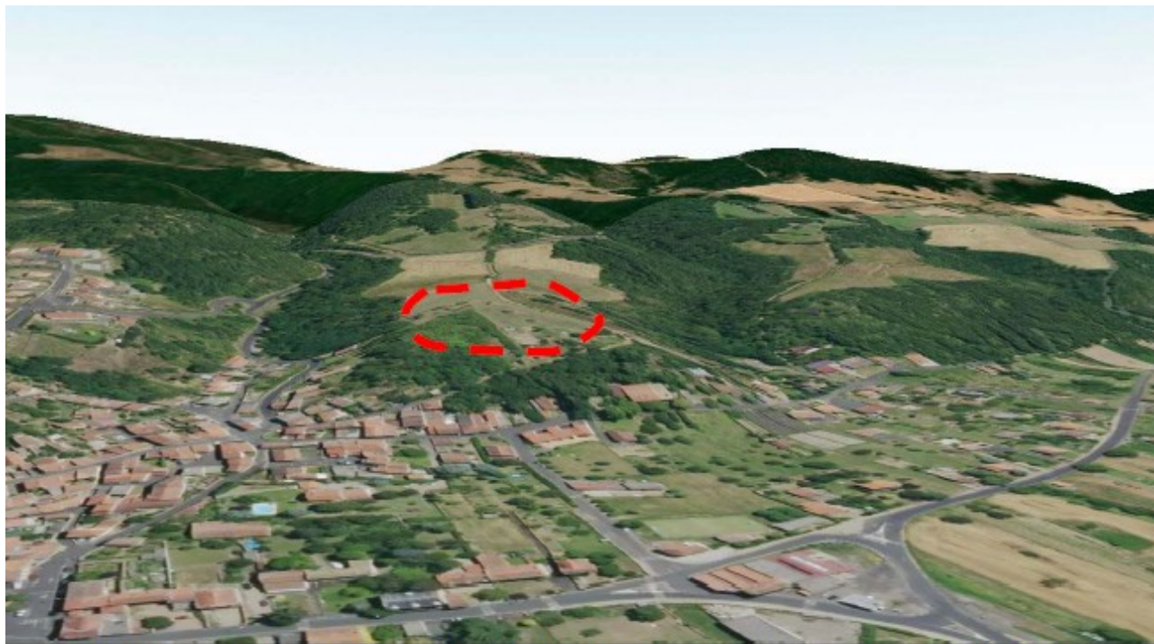
Localisation du site de la Maille vis-à-vis de l'urbanisation du bourg – Source : Google Earth
