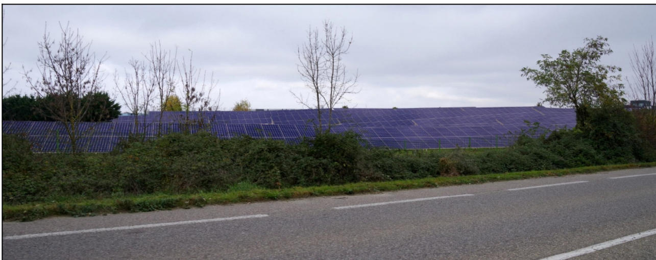
Figure 5: Vue depuis la RD29 au sud du projet (source dossier)
