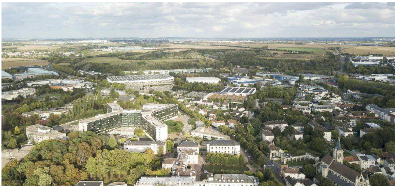
Figure 2: vue aérienne du site avant démolition (NP, p. 20)
