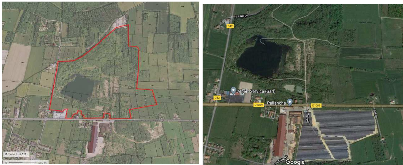
Figure 2:: Localisation de la zone d'étude (source : étude d'impact p.42 et photographie 2021 source google maps avec un parc photovoltaïque récemment construit )
