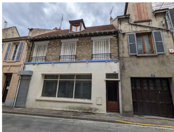
Vacance et bâtiments dégradés du centre-ancien
