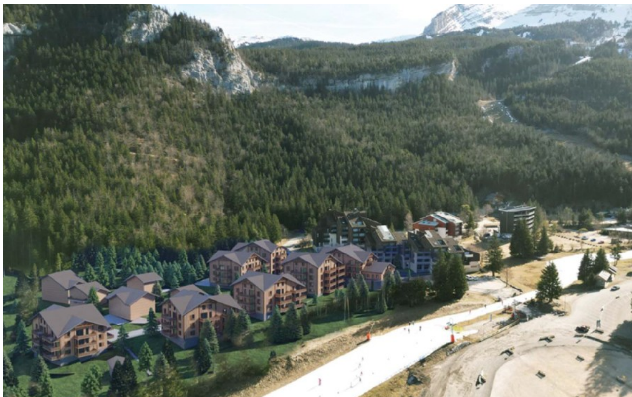
Figure 3: Vue aérienne du projet - Source : étude d'impact
