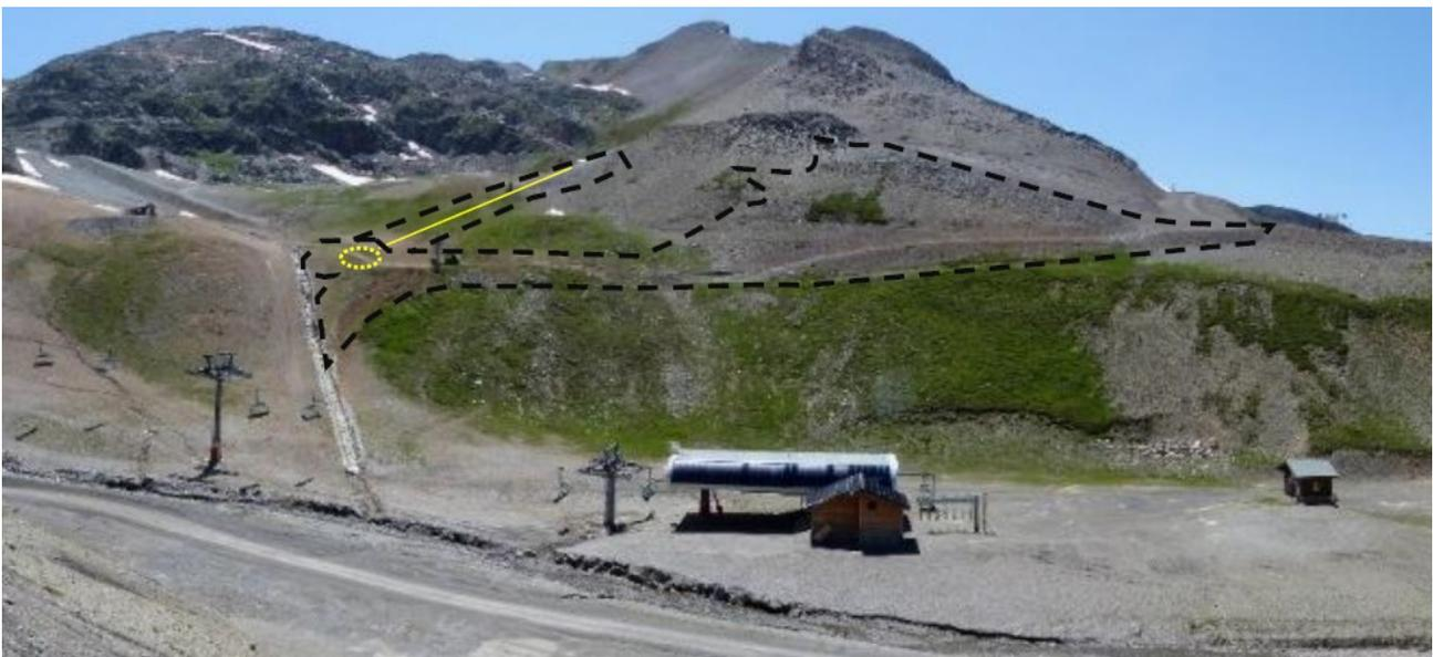
Figure 1: Figure 1: Zone de terrassement, et tracé du télési de l'Envers, au dessus de la gare aval du Toura (en jaune : nouveau télési ; en pointillés noirs : zone de terrassement) - Source : dossier
