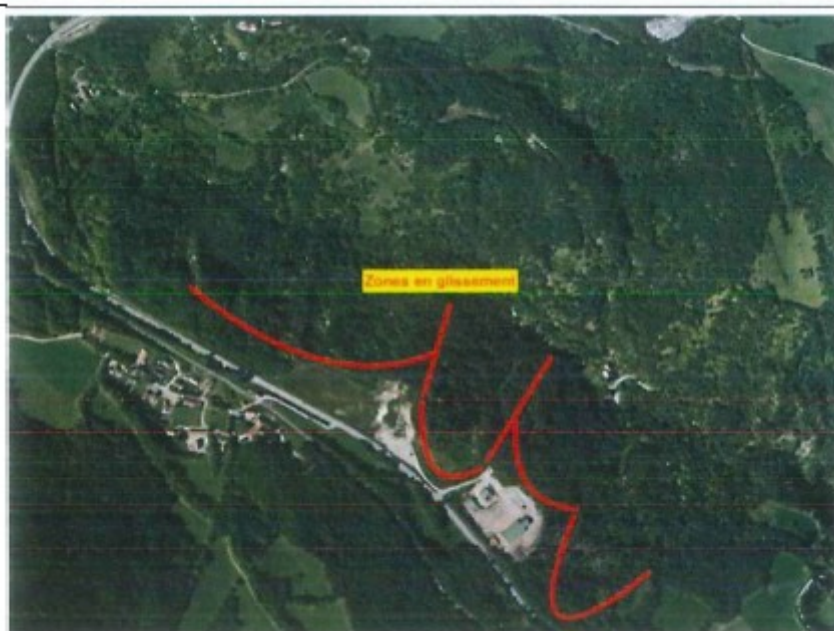
Figure 9: Zones de glissement de terrain (source : dossier)
