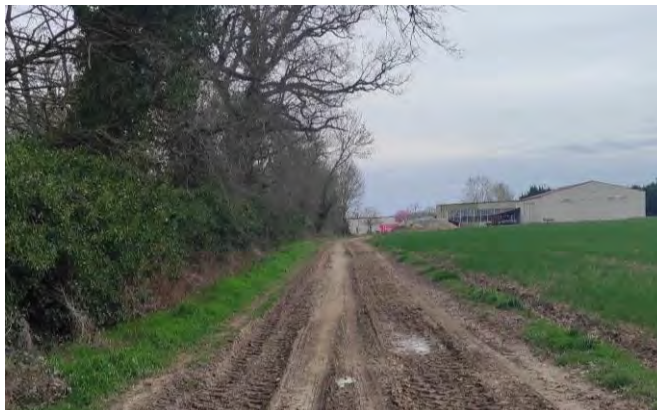
Chemin des noyers à gravillonner
