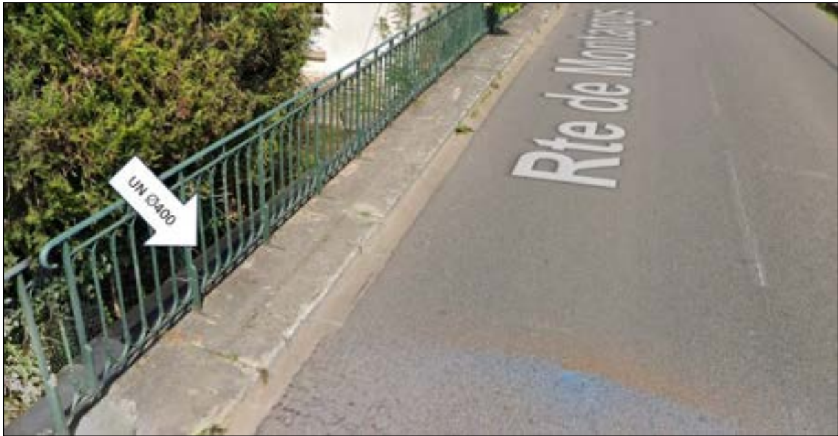
Figure 2-22 : Passage en encorbellement de la canalisation UN en aval de la Rue Charles de Gaulle
