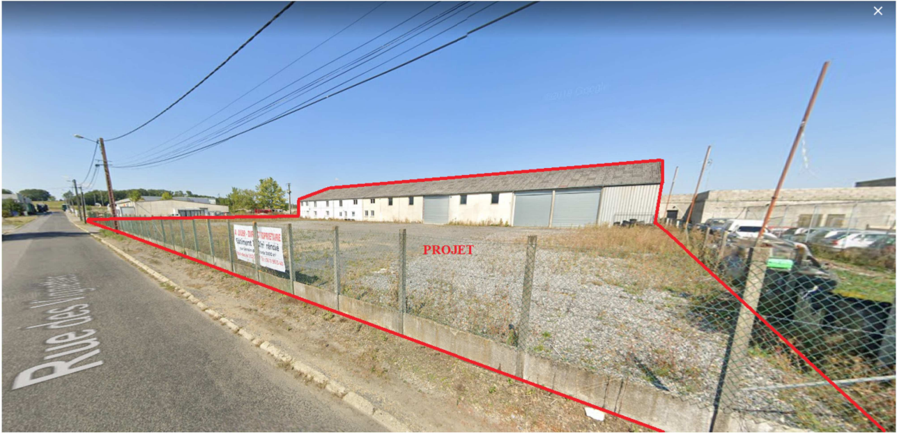
Prise de vue photographique du site du projet (source : google.fr)
