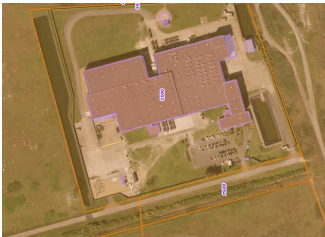
Vue du bâtiment existant (page 2 de la pièce jointe n°2 du dossier)
