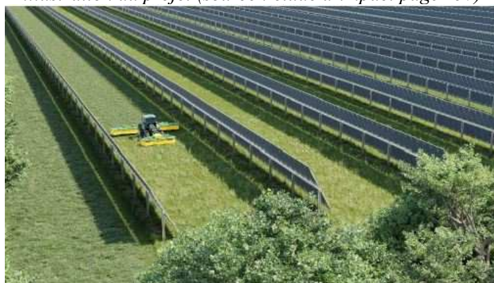
Figure 76 : Illustration de la culture de fourrage en agrivoltaïsme (source : European Energy)
