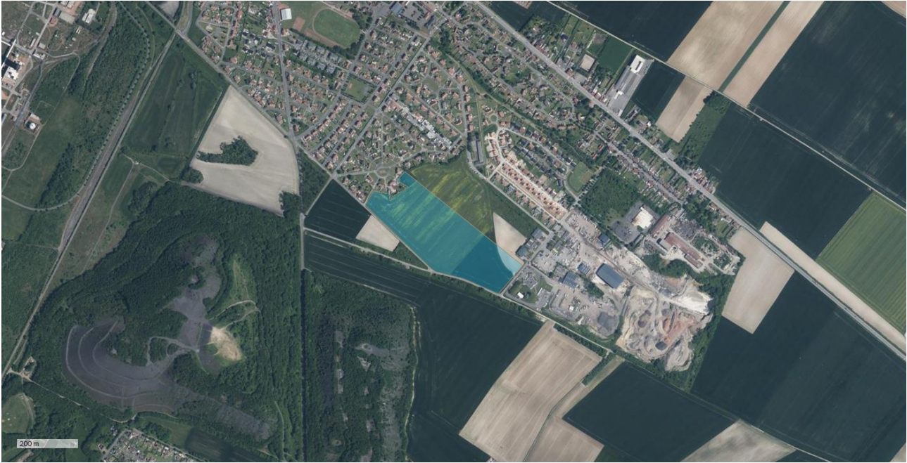
Vue aérienne du site d'implantation du projet dans son environnement (DREAL Hauts-de-France)
