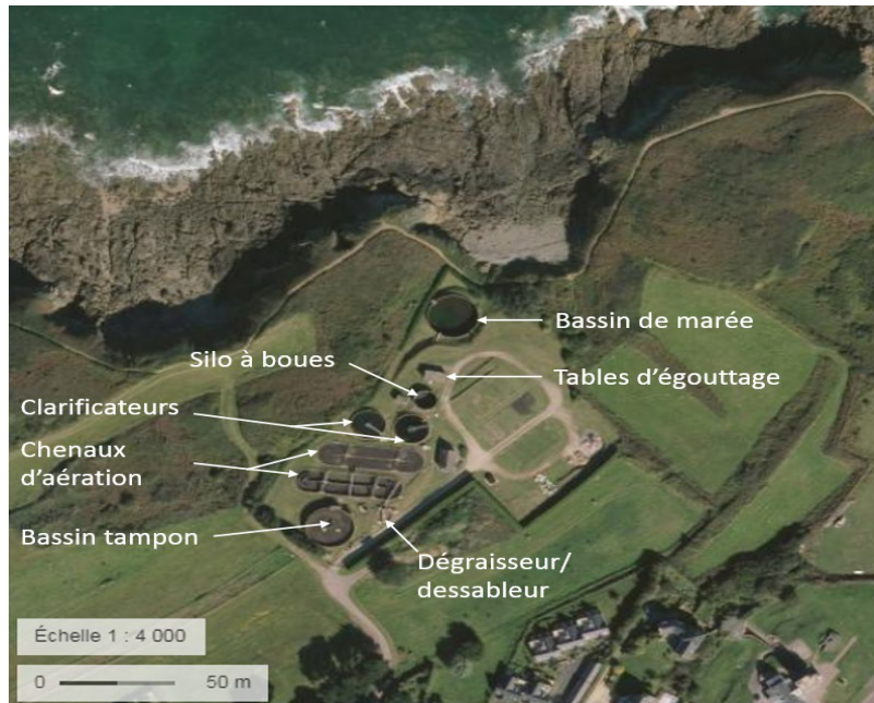
Image aérienne de la station d'épuration du Sémaphore de Saint-Cast-le-Guildo (source : Géoportail)
