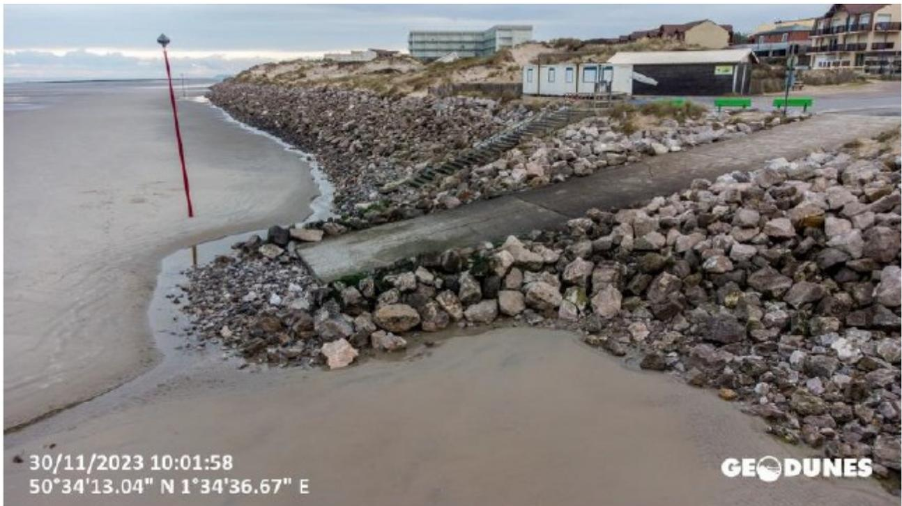
*Niveau d'ensablement constaté fin 2023, montrant l'abaissement du niveau de la plage et un affouillement important en pied d'engrochement (page 33)*
