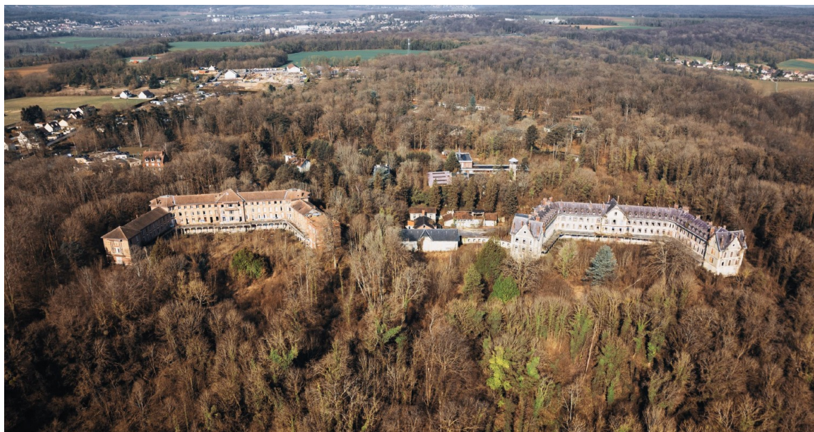
Vue aérienne du site (source : annexe 1 support de présentation)
