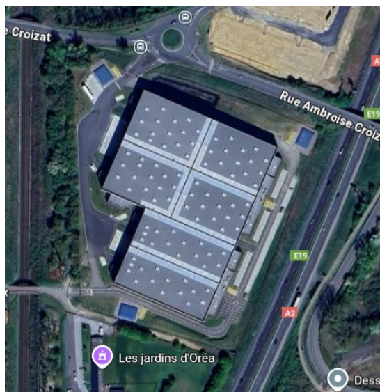
Présentation du site actuel tel que construit (vue aérienne non fournie dans le dossier, source : Google Maps)
